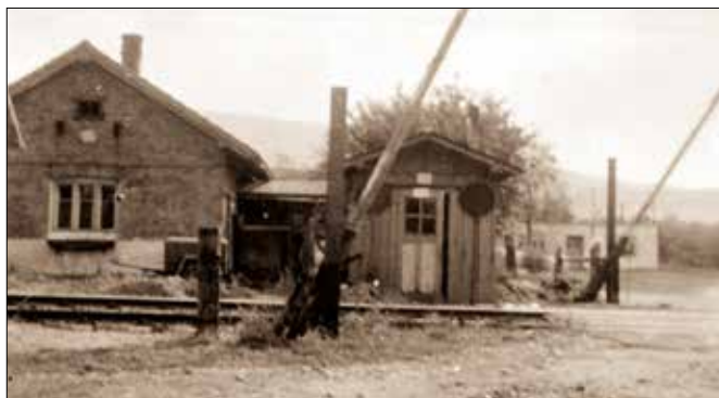
Strážní domek nazývaný také „Vochtrovna“, vystavěn se stavbou železniční dráhy v letech 1882-1886. Strážníci, kteří zde sloužili: Ignác Pospíšil, František Kolařík č. 56, František Nesrsta, rodem z Dobrotic, ruský legionář a posledním byl Jindřich Kolařík č. 56. Foto kolem roku 1955.
