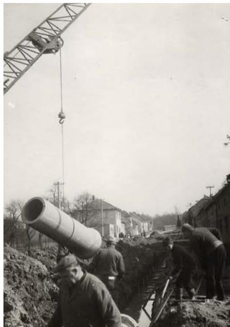
V roce 1971 se v obci budovala kanalizace.
