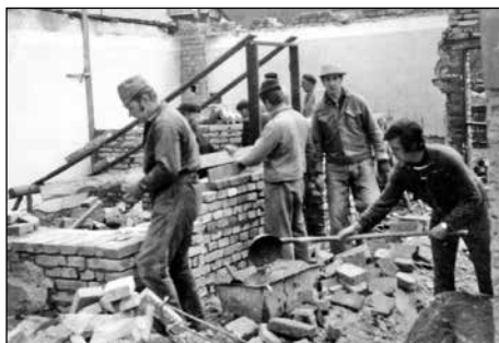
Vyzdívání vnitřních zdí budovy
