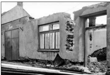
Demolice staré budovy MNV
