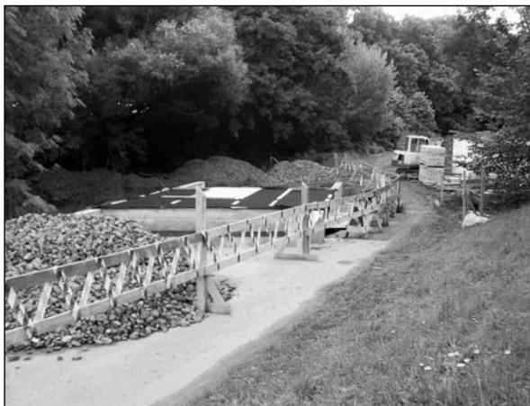
Stavba mostu (červenec 2011)
