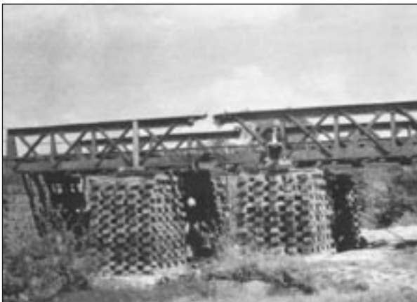
Provizorní most přes řeku Rusavu
