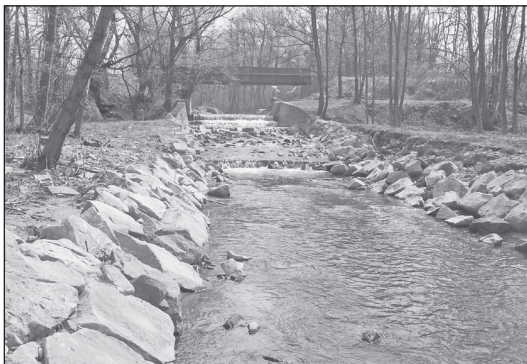
Opravené koryto Rusavy poškozené jarní povodní (vpravo).
