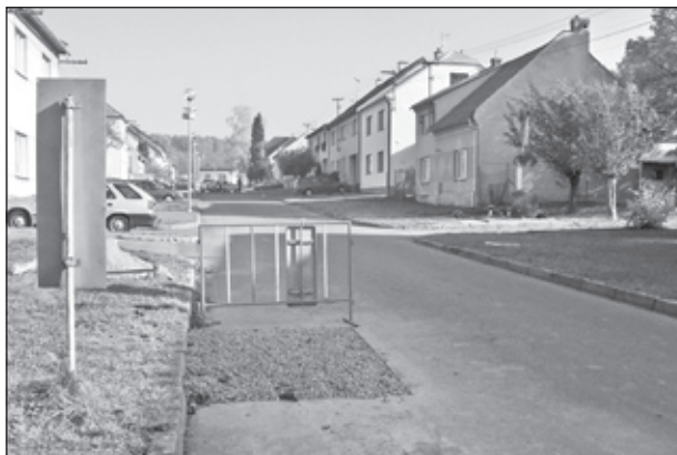
Proběhl první průzkum potrubí a takto by měly vypadat i výkopy pro nově vedené potrubí.
