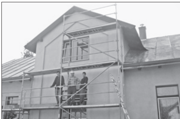
Dělníci při opravě fasády budovy bývalé školy.
