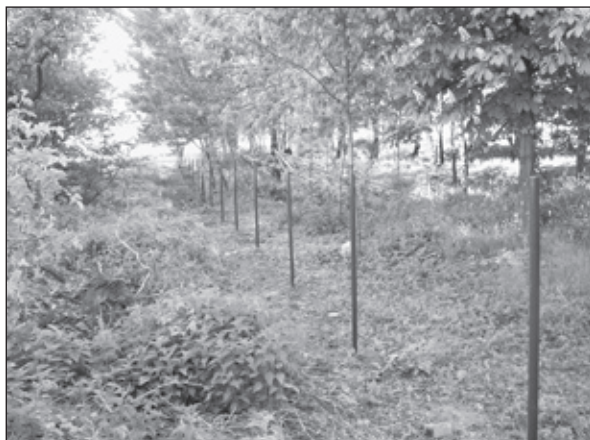
Příprava sloupků pro nové oplocení Hájíčku.
